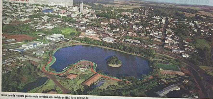
Município de Ivaiporã ganhou mais território após revisão do IBGE FOTO: ARQUIVO TN
